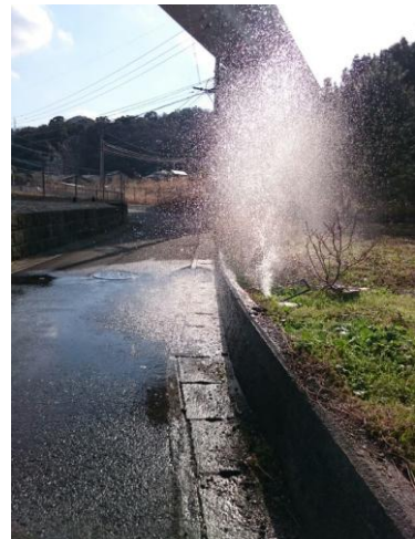
2016年1月25日10時45分 大分県津久見市 「水道管が破裂しています！」
